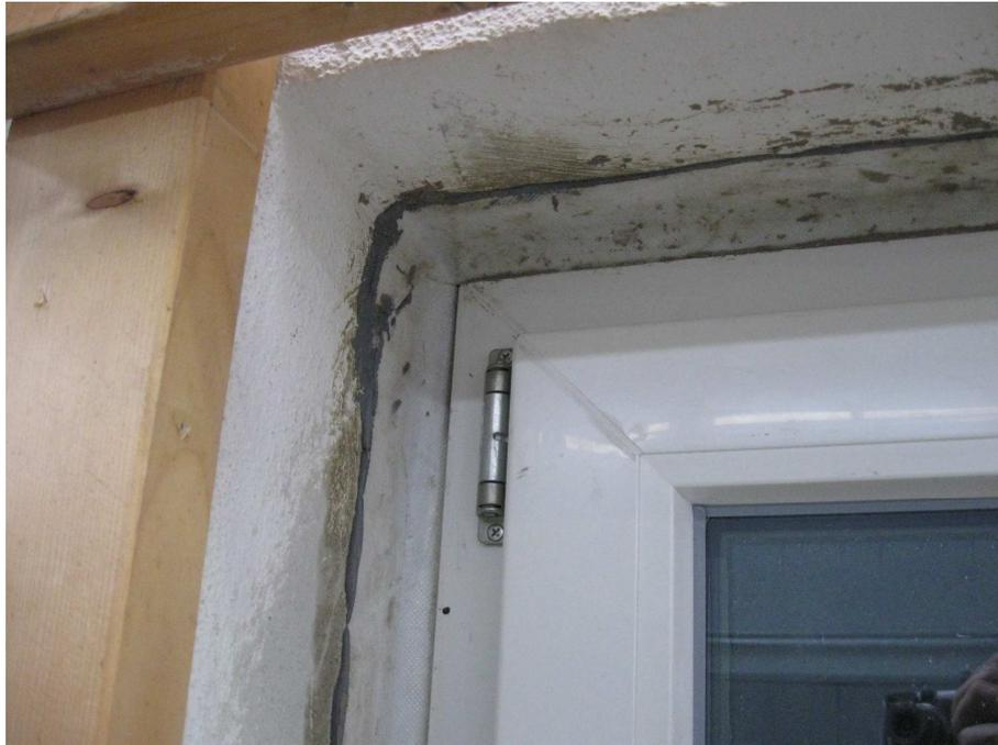
**Bild 1** Raumseitige Abdichtung mit GU-Fensterdichtband Innen Alu, Detail obere Eckausbildung.
