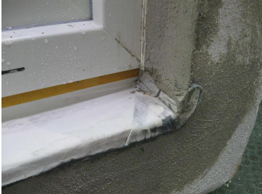
**Bild 3** Außenseitige Abdichtung mit GU-Fensterdichtband Außen, Detail untere Eckausbildung.
