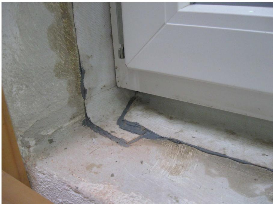
**Bild 2** Raumseitige Abdichtung mit GU-Fensterdichtband Innen Alu, Detail untere Eckausbildung.
