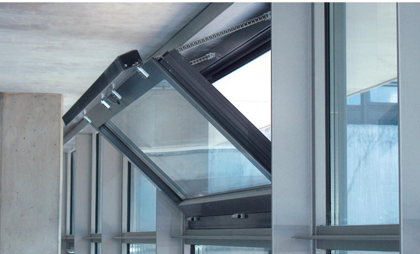
Gli azionamenti e i sistemi di apertura RWA garantiscono un'apertura sicura e affidabile per l'estrazione del fumo in caso di incendio e un'aerazione naturale dell'ambiente nella vita di tutti i giorni. Dalla gamma completa di attuatori a catena, a fuso e di chiusura nonché di sistemi di apertura e chiusura, è possibile scegliere la soluzione su misura per qualsiasi specifica applicazione.
