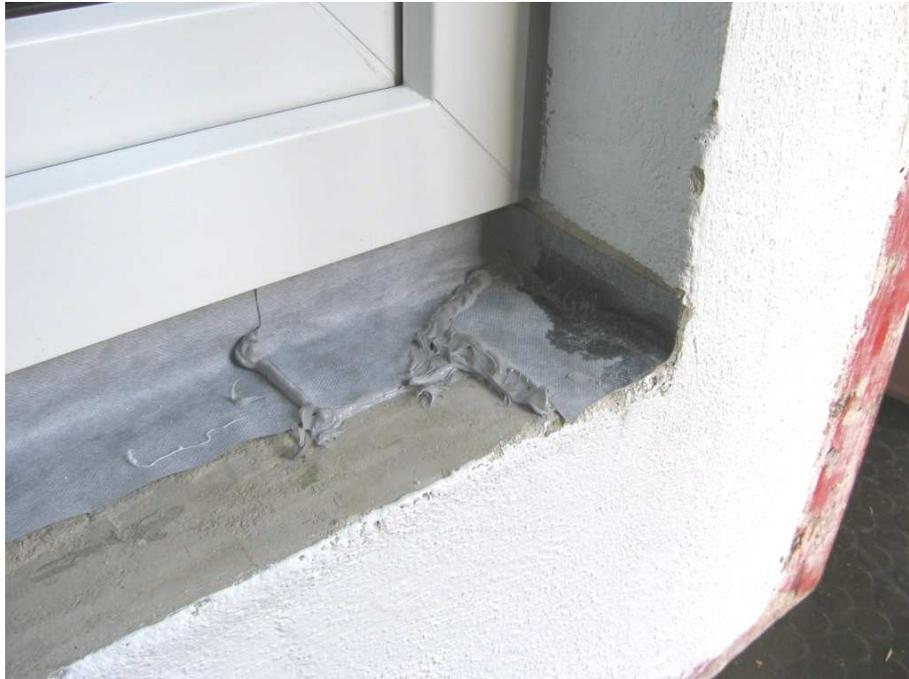
**Bild 3** Äußere Abdichtung mit GU Fugendichtstoff Außen + GU Rundschnur (seitlich und oben) und GU Fensterdichtband Außen + GU Ultra Dichtmasse (unten). Fensterbank noch nicht montiert.
