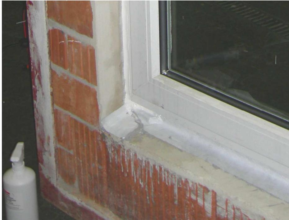
**Bild 1** Abdichtung innen mit GU Fugendichtstoff Innen + GU Rundschnur (seitlich und oben) und GU Fensterdichtband Innen + GU Ultra Dichtmasse (unten).
