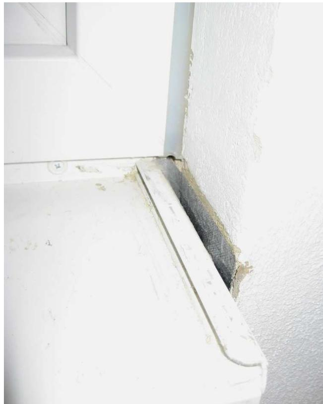
**Bild 4** Aluminiumfensterbank montiert. Seitliche Abdichtung zwischen Endstück und Leibung noch nicht ausgeführt.
