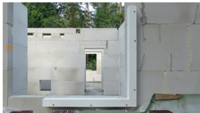
Geeignet für alle Profiltiefen und Rahmenmaterialien. Insbesondere geeignet für den Einsatz in zweischaligen Klinkerfassaden: Hier löst die GU-Vorbauzarge mit höchster Effizienz die Anforderungen an Lastabtragung, Wärmeschutz, Winddichtigkeit und Schallschutz ein
