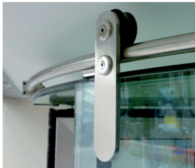
Nachtverschluss außen liegend – Glasflügel mit Punkthaltern
