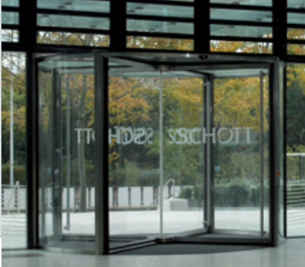
Schott AG | MAINZ | J • S • K Architekten | Typ GGG | vollautomatisch | 4-flügelig | edelstahlbeplankt | Nachtverschluss | Unterflurantrieb
