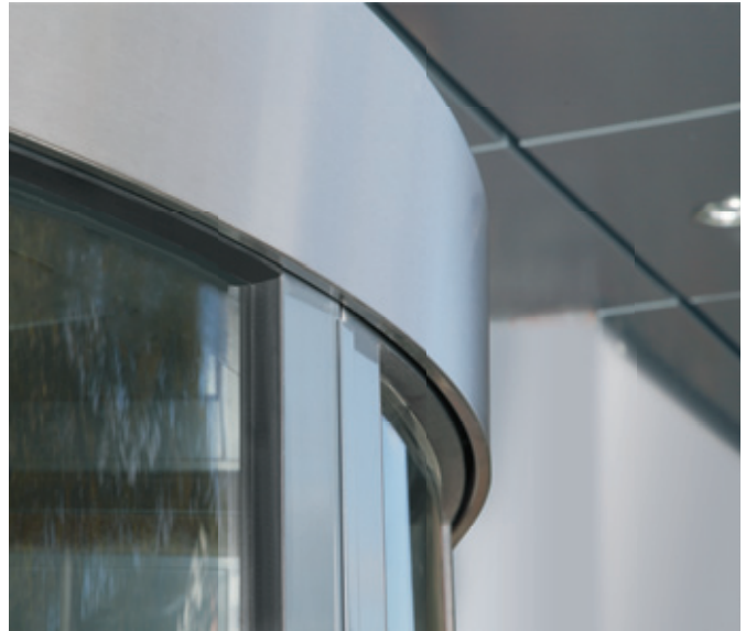
Nachtverschluss außen liegend – geschlossen
