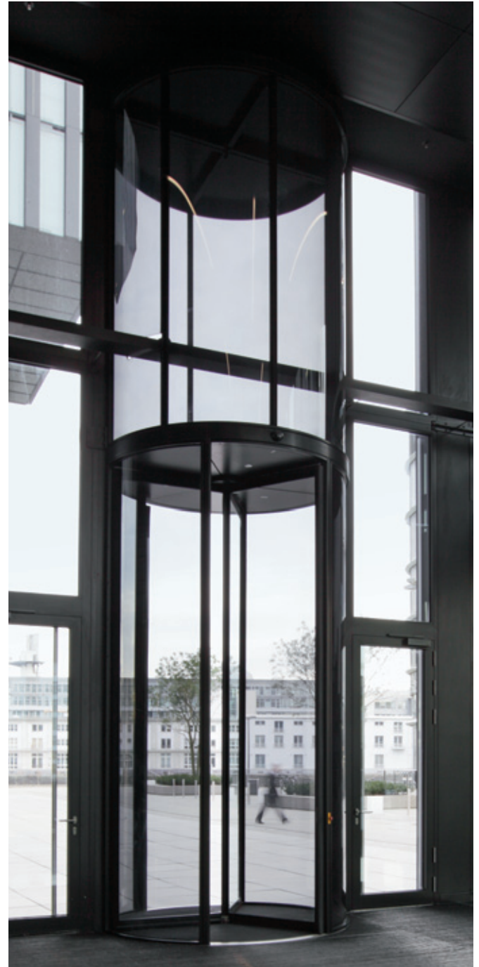
BÜROTURM HAFEN-CITY | DÜSSELDORF | J • S • K Architekten GRA in Sonderausführung | vollautomatisch | 3-flügelig | Durchmesser 2280 mm | Gesamthöhe 7860 mm
