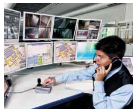
Auch technologisch unterschiedliche sicherheitstechnische Anlagen können zusammengeführt und in einer Oberfläche visualisiert werden
