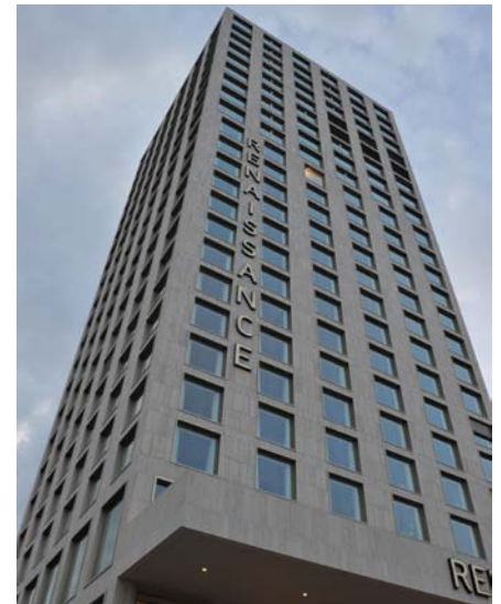
Mobimo Tower, CH-Zürich · Diener & Diener Architekten, CH-Basel
